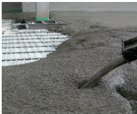
Béton coulé avec l'ajout de Mapefibre NS18 contre le retrait plastique
