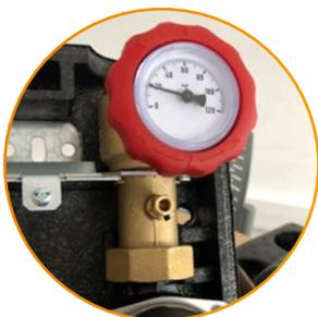
Avec doigt de gant porte sonde Ø 6.
